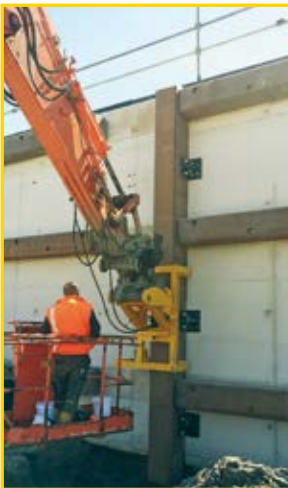
Kantelbare hydraulische klem voor houten balken Tilting hydraulic clamp for wooden beams
